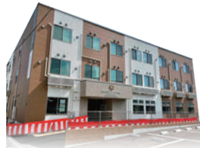
サービス付き高齢者向け住宅 スイートガーデン千里山 〒565-0837 大阪府吹田市佐井寺南が丘12-21
